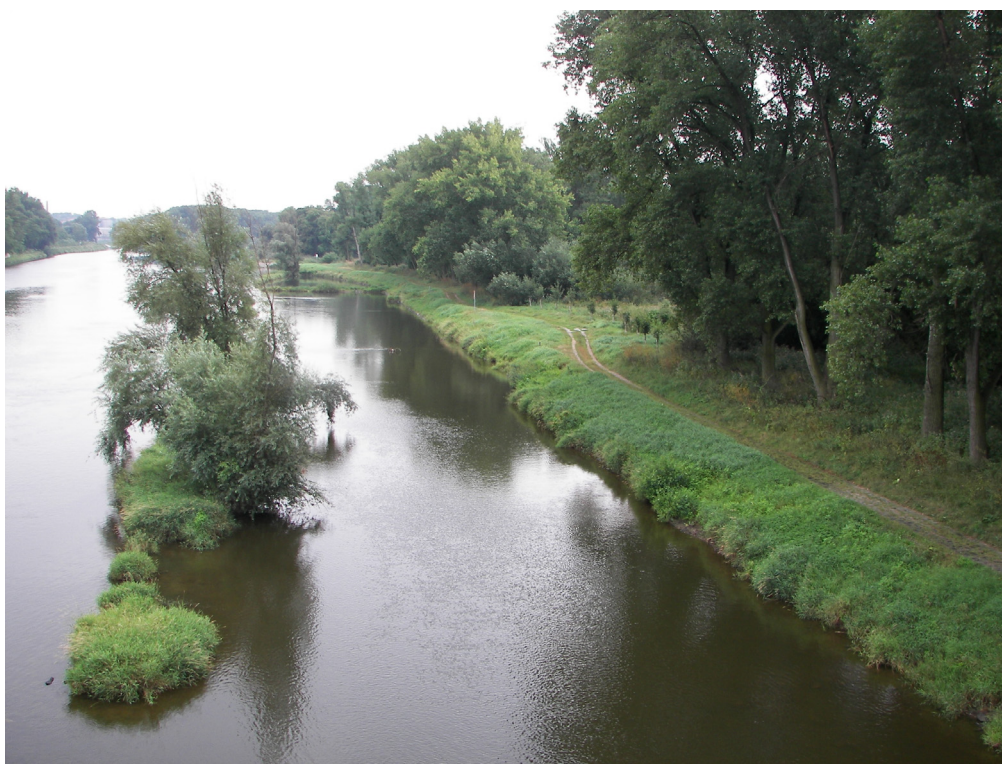
Obr.4 Prostor budoucího přístaviště malých lodí, v tomto prostoru budou realizovány úpravy toku
