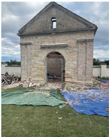
Márnice na hřbitově ve Vrbně po otloučení nevhodných omítek a vytvoření původních stavebních otvorů.
